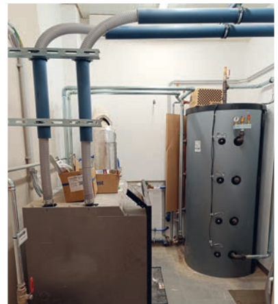
Die alte Gasheizung wurde durch eine moderne Pelletsheizung ersetzt.
